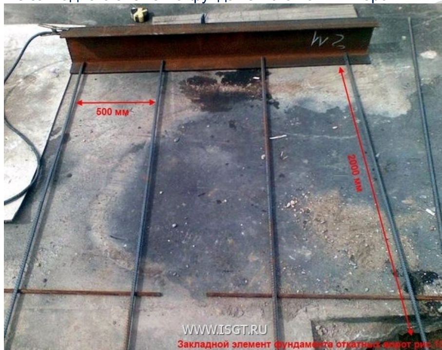
На рис. 13 показан закладной элемент фундамента откатных ворот
