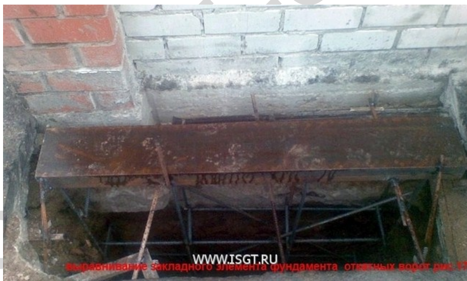
На рис. 17 показано выравнивание по продольной оси закладного элемента фундамента откатных ворот
