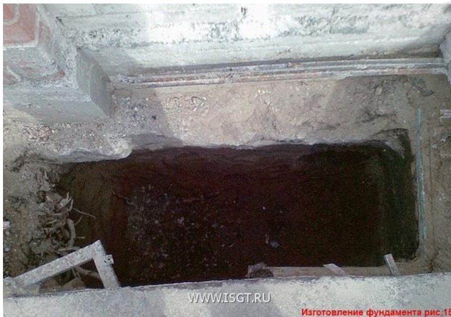
На рис. 15 показан котлован фундамента закладного элемента откатных ворот
